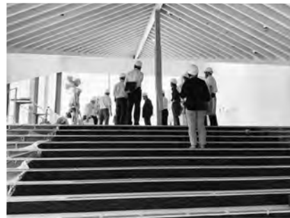
足柄支所が入る交流センターを視察
