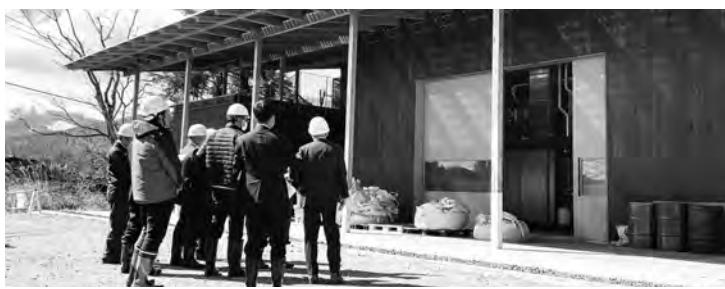
最近では良好な運転が続く森の金太郎発電所（総務建設委員会にて現地視察）
