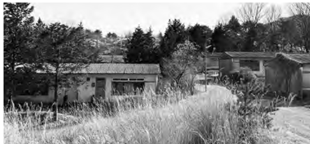
解体される滝の台の町営住宅の跡地利用は
