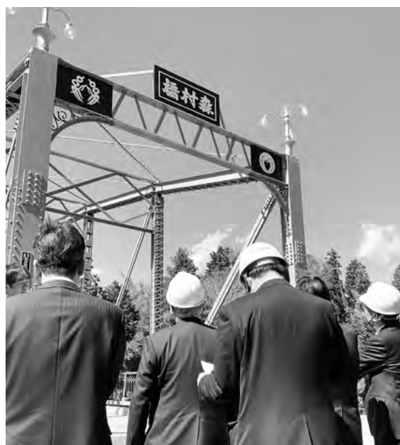
完成間近の森村橋（文教厚生委員会での現地視察）
