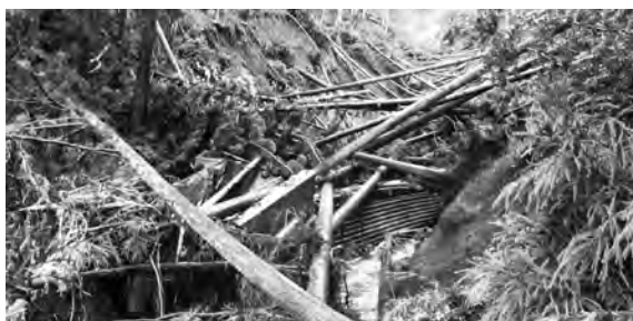
湯船排水路災害現場
