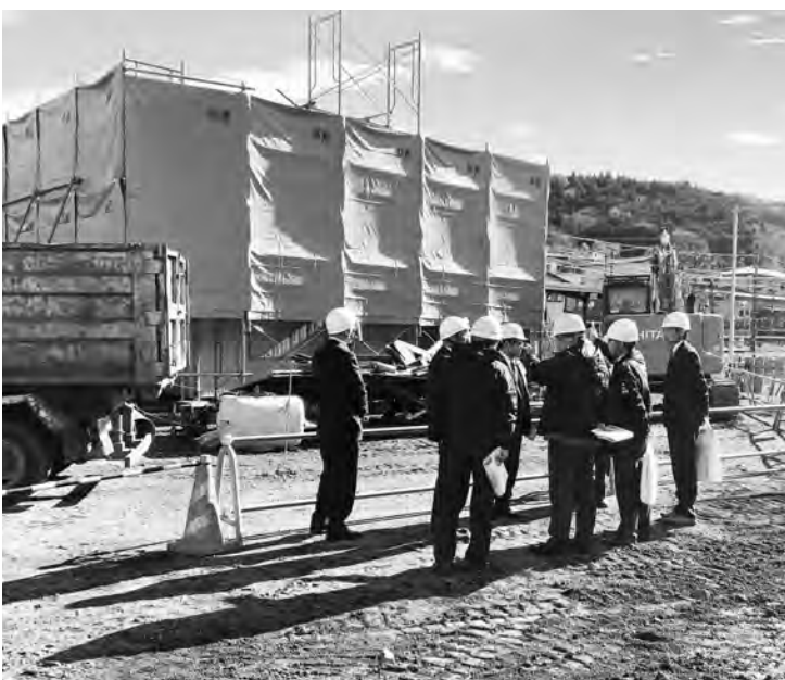
解体中のJR足柄駅舎を委員会で現地視察
