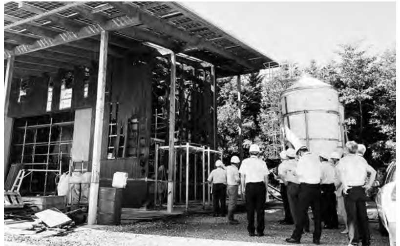
総務建設委員会で現場を確認
