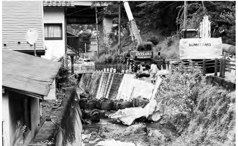
滝沢川の災害復旧現場
