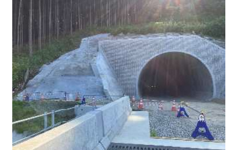
④東側下り線坑口
