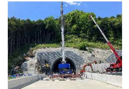
④東側下り線坑口
