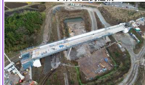
橋桁を構築中
