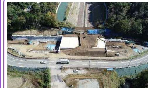
大型ブロック積、コンクリートブロック積を施工中
