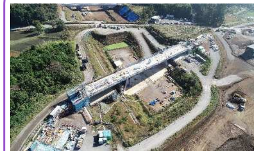
橋桁を構築中
