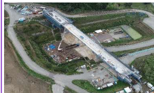
橋桁を構築中
