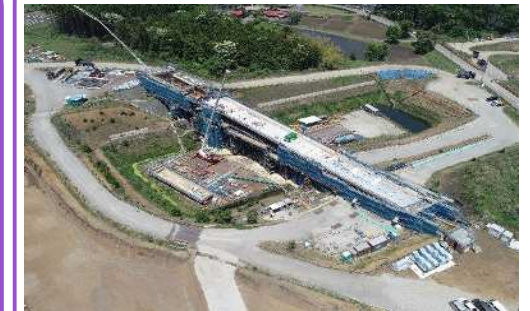
橋桁を構築中
