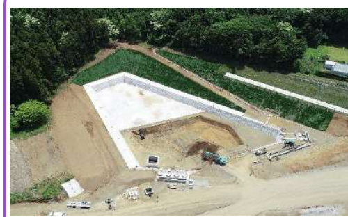
調整池を施工中
