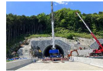
④東側下り線坑口
